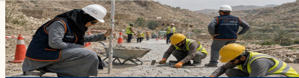
متابعة ترابط الأحجار وضبط المناسيب وسلامة موقع العمل أثناء التنفيذ Monitoring stone interlocking, levels, and site safety during execution.
