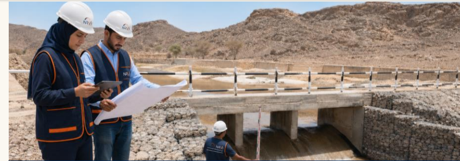
فحص قنوات التصريف والعبارات والحماية الحجرية قبل اعتماد الأعمال Inspecting drainage channels, culverts, and stone protection before work approval.
