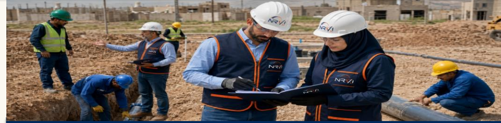
توثيق تنفيذ الشبكات والخطوط وغرف التفتيش ضمن خطة رقابة ميدانية Documenting network installation, pipeline alignment, and inspection chambers under field
